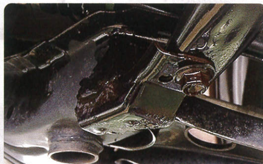
シフト錆轉換剤 塗布
